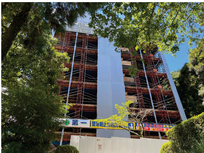
■ 五重塔側面付近
