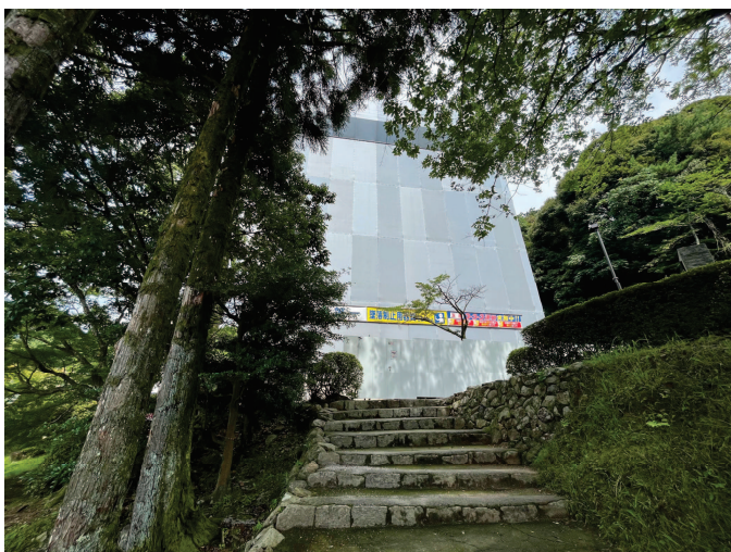
■ 五重塔側面付近
