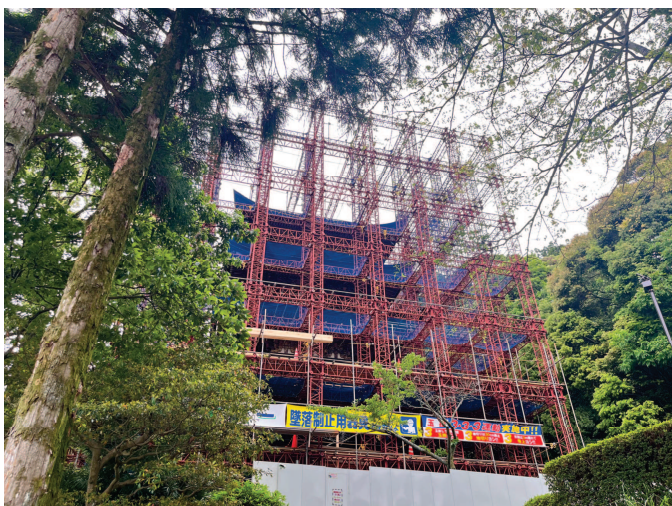
■ 五重塔側面付近
