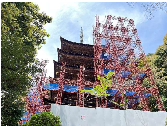
■ 五重塔側面付近
